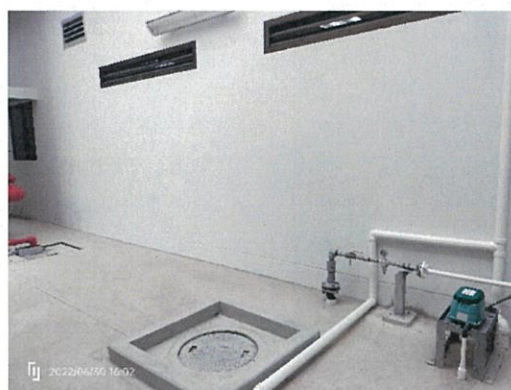
ภาพที่ 2-8 ระบบบำบัดน้ำเสียสำเร็จรูป
