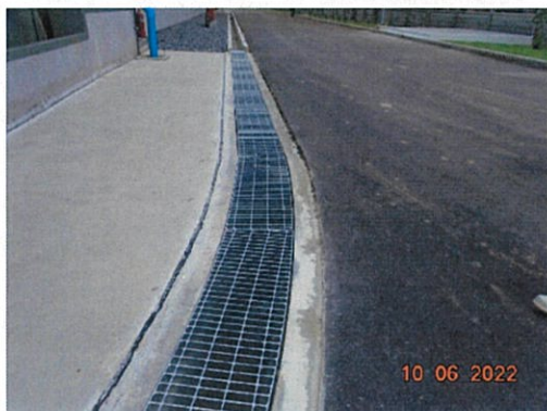
ภาพที่ 2-13 ระบบระบายน้ำฝน
