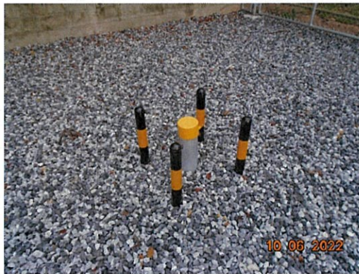
GW6 : ริมรั้วโครงการระยะที่ 2 ทางทิศตะวันออก ภาพที่ 2-9 บ่อสังเกตการณ์ (Monitoring Well)
